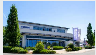
Blick auf den Sitz der Stadtwerke Forchheim GmbH
